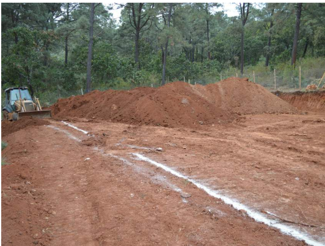
Construcción de centro de cómputo de dos niveles
