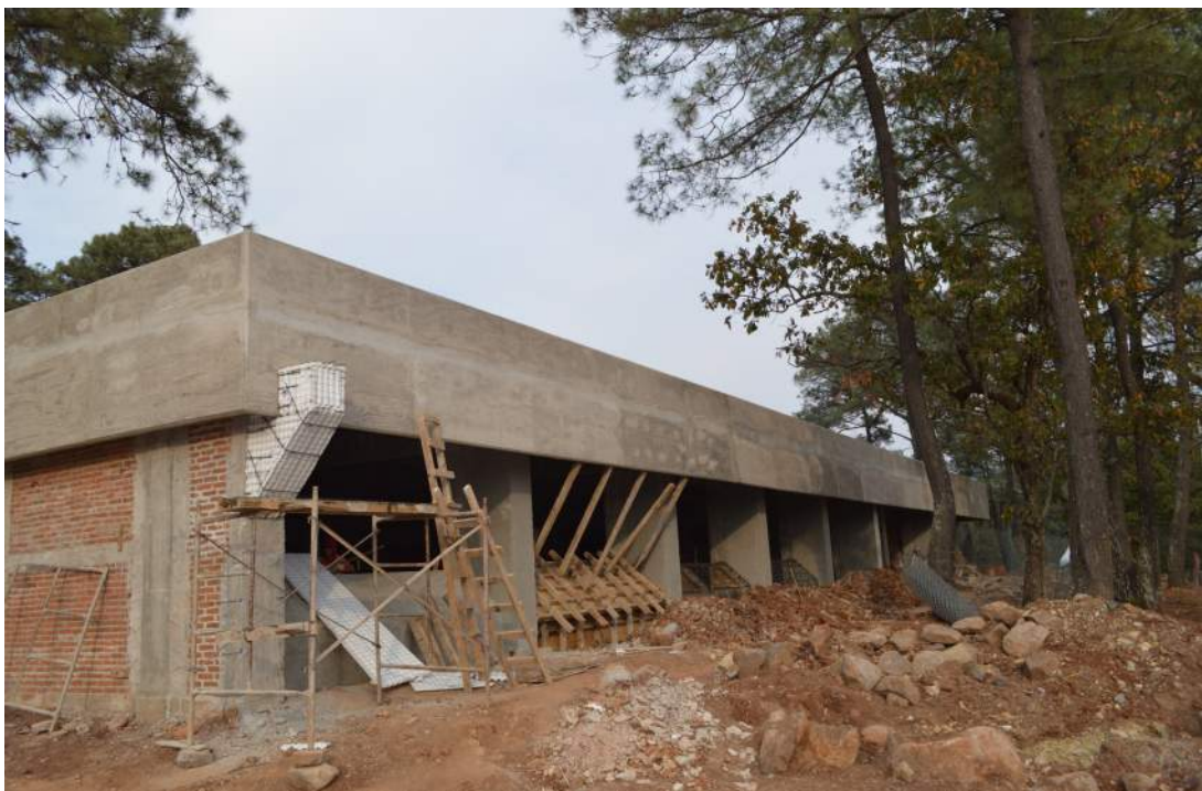
Construcción de biblioteca de una planta
