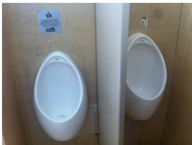
Reparación de sanitarios
