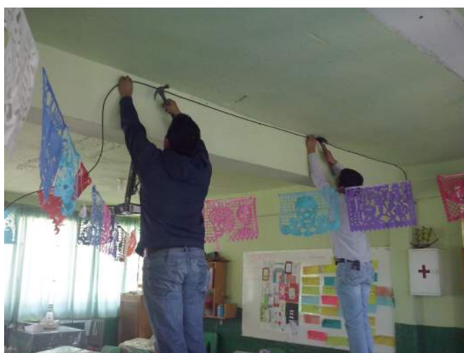
Instalación de equipo
