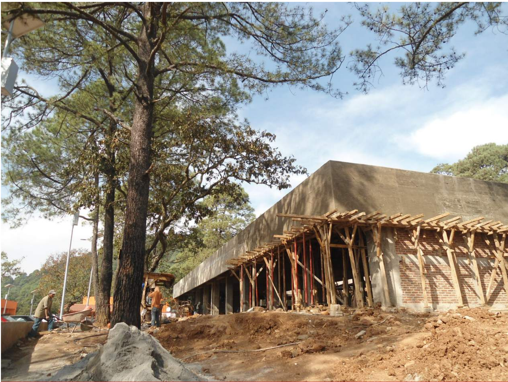
Biblioteca en construcción
